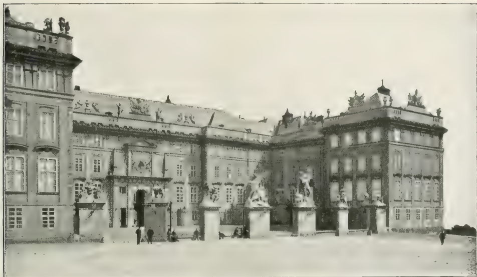
La façade du Château royal.
